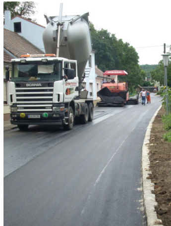
Asphaltierungs- arbeiten in Loosdorf
