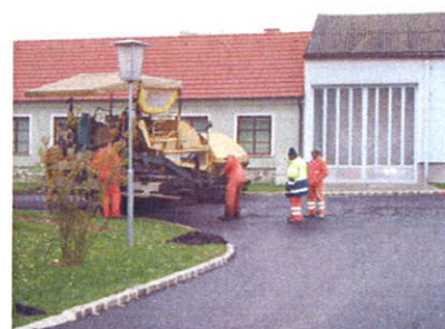
Asphaltierungsarbeiten Hagendorf Oberort
