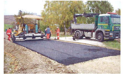
Asphaltierungsarbeiten: links: Fallbacher Weg unten: Asphaltierung Neuhofstraße
