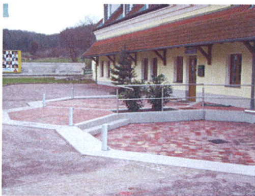
Eingangsbereich Winkelauer Hof, Loosdorf
