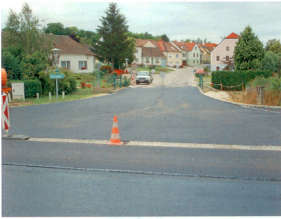
Asphaltierungsarbeiten in Fallbach
